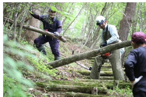
倒木の伐採除去作業（室根古道）
